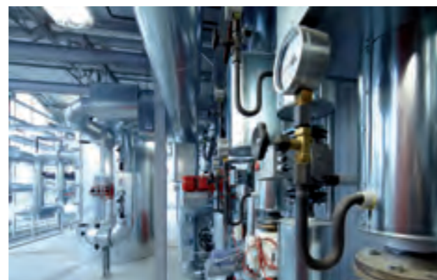
Klimasteuerung im neuen Gewächshaus
