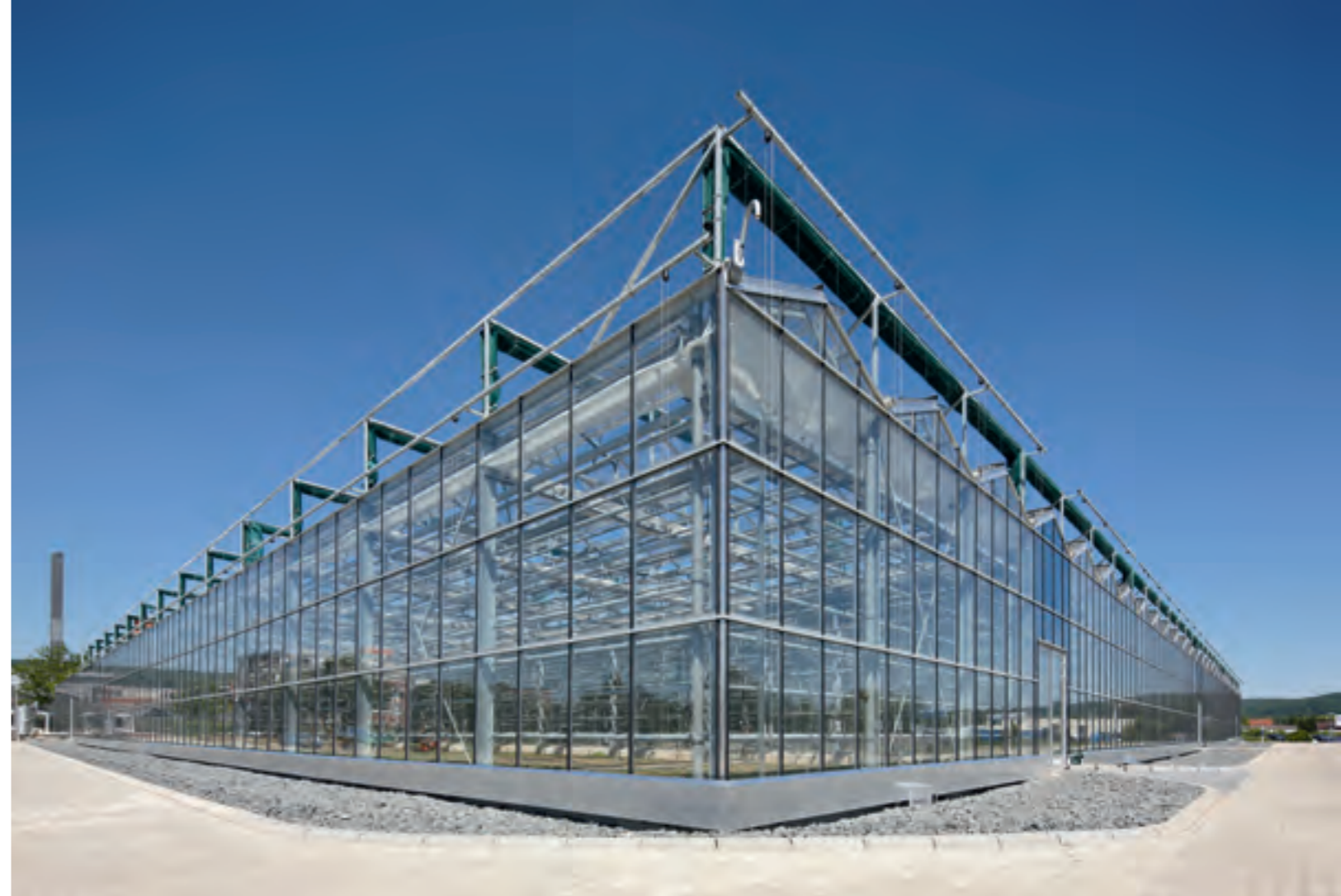
Eine Konstruktion aus Stahl und Glas auf 6.800 m 2 Gewächshausfläche – Energieeffizienz war die größte Herausforderung.
