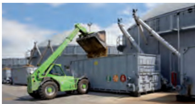
„Fütterung“ der Biogasanlage mit Biomasse
