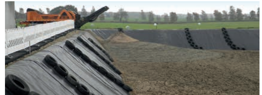
Abb. 31: Einfache Befüllung des Folienbeckens direkt mit dem Schredder
