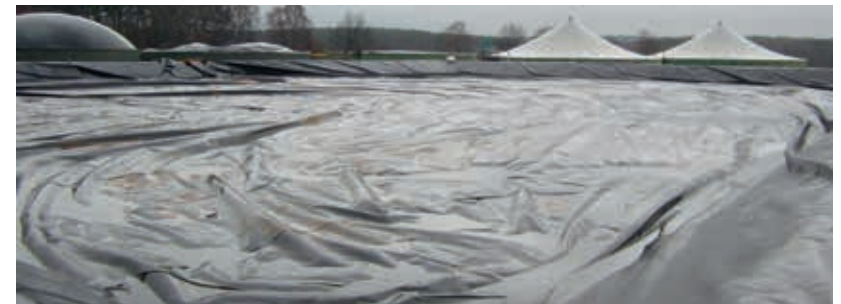
Abb. 32: Abdeckung des Folienbeckens, um Verluste zu reduzieren
