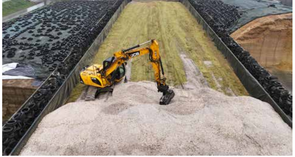
Zuckerrüben-Bröckel „on top“ als oberer Abschluss im Silo haben den Vorteil, dass sie auch zeitlich versetzt nach der Mais- bzw. Grassilierung aufgebracht werden können.
